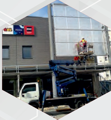
Usluga montaže skelom i autokošarom
