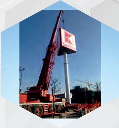
Usluga montaže kran-dizalicom do 40m visine i 40T težine
