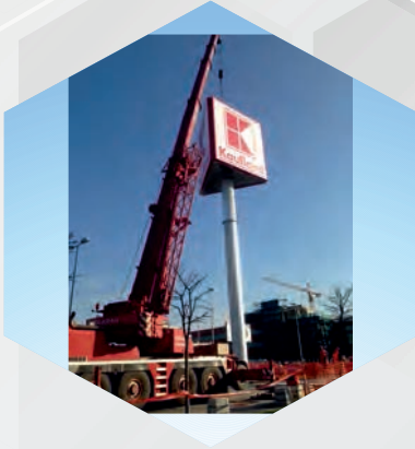
Montagedienstleistungen mit Hochbaukran bis 40 m Arbeitshöhe und 40 t Gewicht
