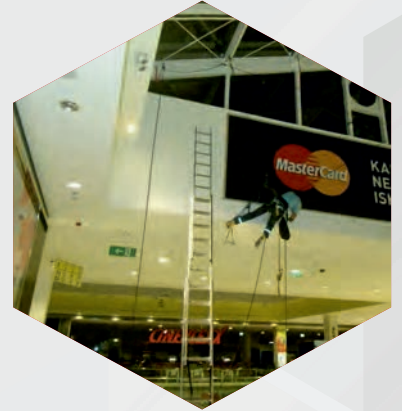
Montagedienstleistungen mit Hilfe von zertifizierten Alpinisten
