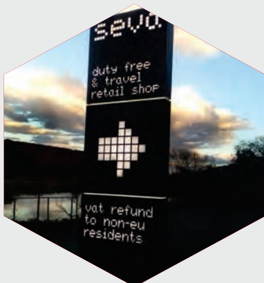
Werbemast aus Alu-Verbundplatte und Plexiglas
