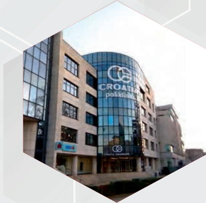
Bekleidung mit Fensterfolien
